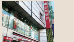
1996年/浅草橋5号館（現・浅草橋本店）
