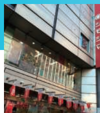
浅草橋5号館（現・浅草橋本店）
