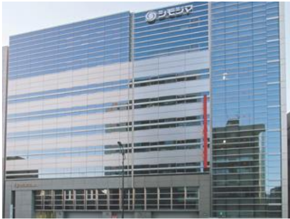
シモジマ本社ビル
