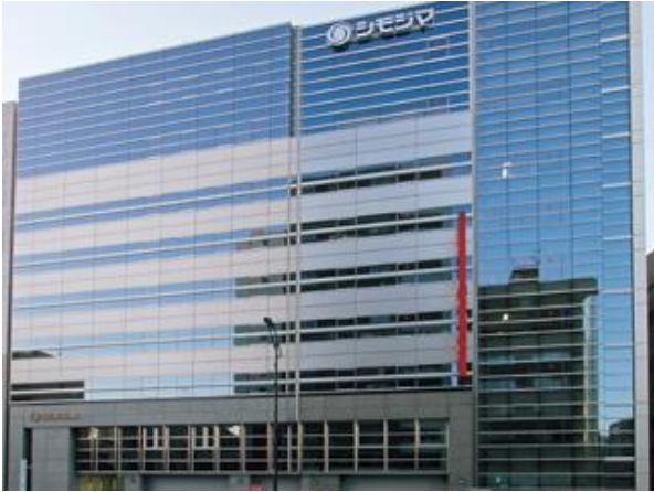
シモジマ本社ビル
