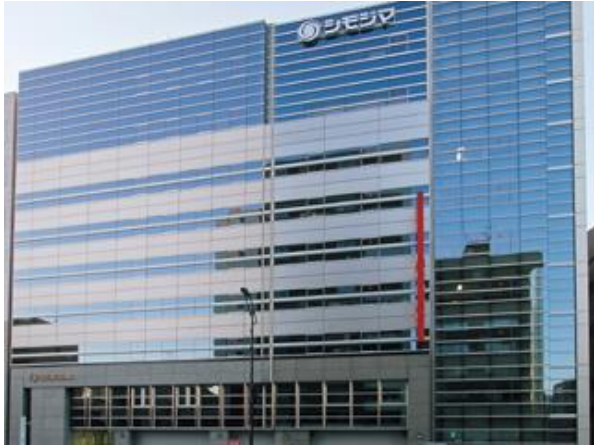
シモジマ本社ビル
