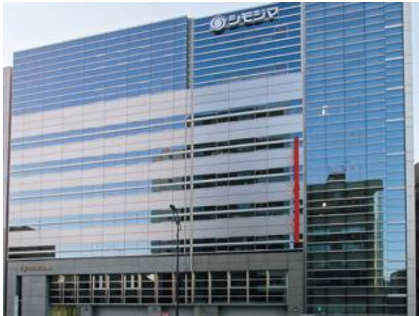
シモジマ本社ビル
